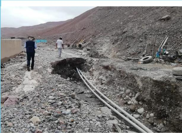
Tramo de Línea de Conducción afectada y Línea de Aducción expuesta por ingreso de Huayco
