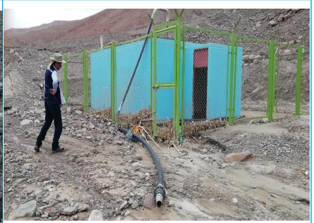
Reservorio de 25 m3., con cerco perimétrico; tubería sobre techo sale para Línea de Impulsión a Tanque de Polietileno de V= 25,000 Lts en Alto Mirave (Zona de Reasentamiento)
